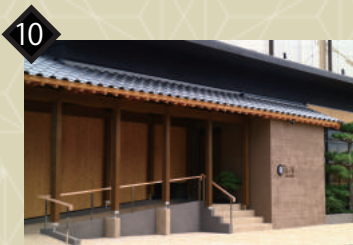
10 湊小宿 海の薫と AWAJISHIMA お疲れ様でした。まずは正面玄関前のスペースにご停車ください。スタッフが駐車場をご案内させていただきます。
